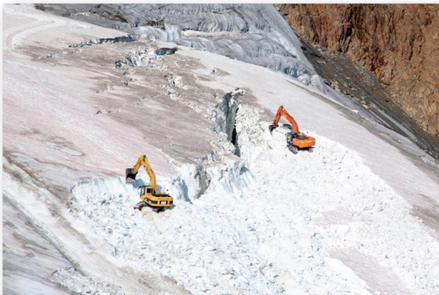
Photo : Travaux sur le glacier Pitztal – 27 août 2019 Source : WWF – Vincent Sufian
